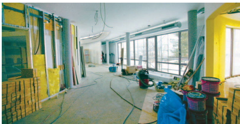
Kabel, Dämpfungsmaterial, Parkett – noch waren viele Handgriffe zu erledigen.
